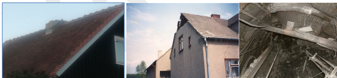
Rys. 1. Przykładowe uszkodzenia wywołane w budynkach po wystąpieniu najsilniejszych zjawisk sejsmicznych w obszarze GZW (dwa rysunki po lewej stronie: fot. G. Mutke) oraz uszkodzenia w wyrobisku podziemnym (tąpnięcie) rysunek po prawej stronie (z materiałów po tąpnięciu KWK Wujek, Ruch Śląsk z roku 2008)
